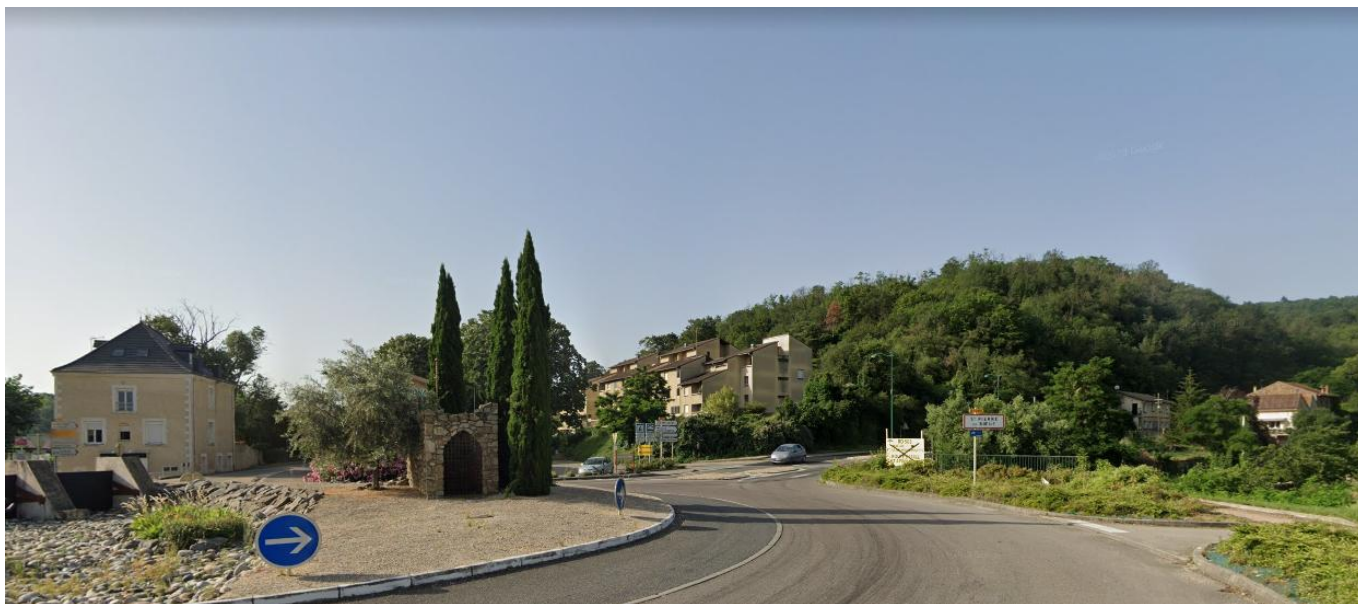
Vue éloignée du bâtiment actuel, depuis la RD1086
