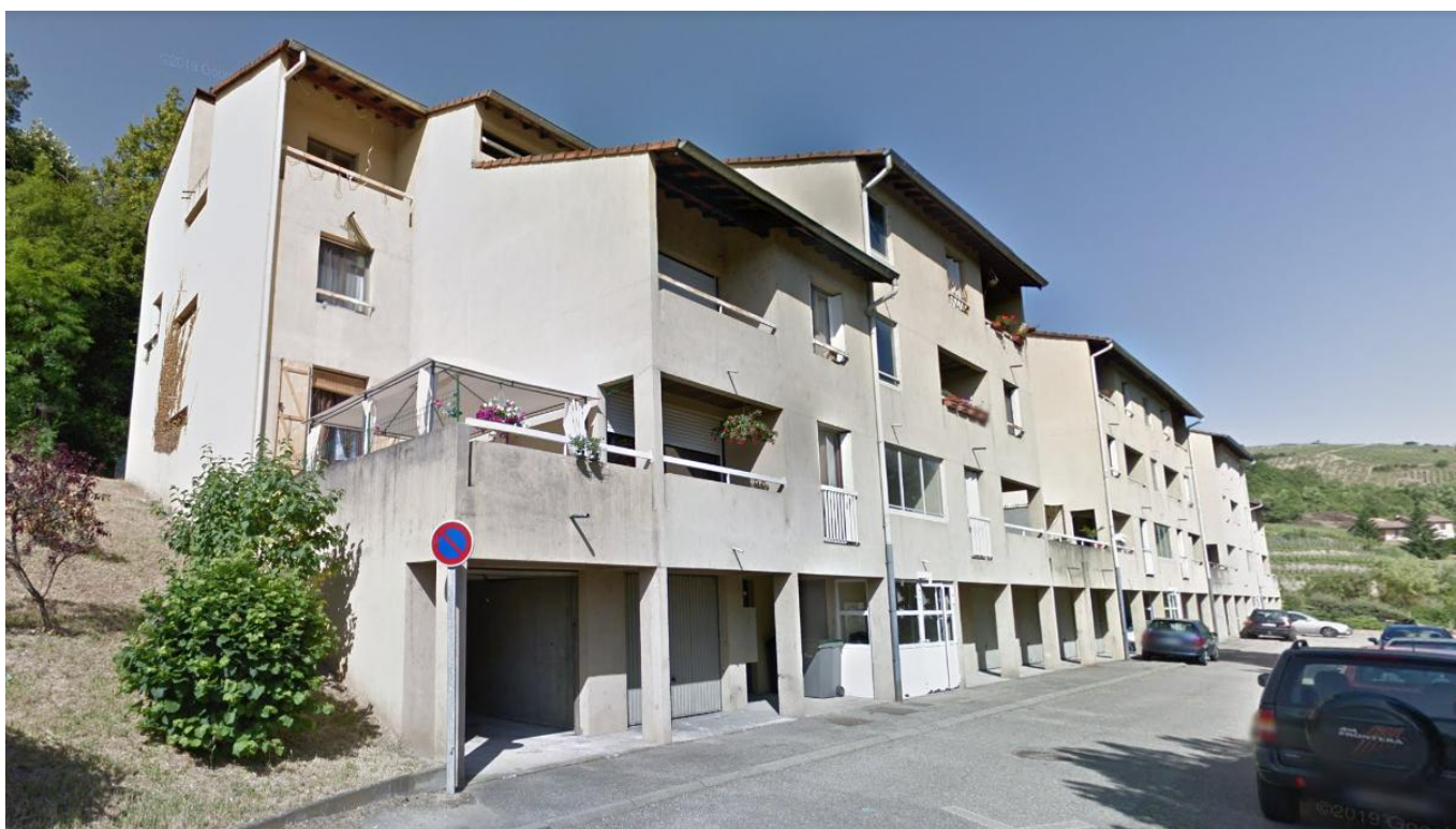
Vue du bâtiment actuel
