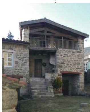
Exemple de débord de toiture
