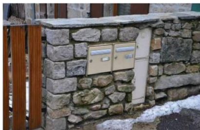
Exemple d'intégration d'éléments techniques
