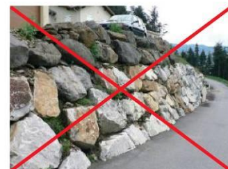
Exemple d'enrochements de type cyclopéen
