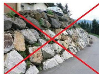
Exemple d'enrochements de type cyclopéen
