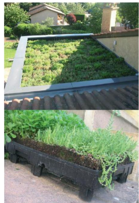
Exemple de toiture-terrasse végétalisée et bacs pré-cultivés
