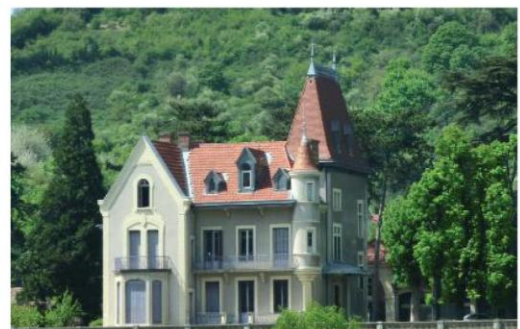
Exemple de toiture «atypique»
